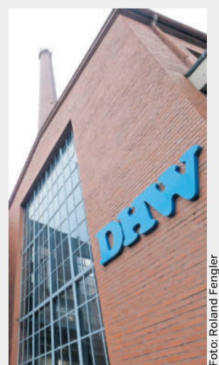
Das alte Hefewerk steht im Mittelpunkt großer Pläne.
