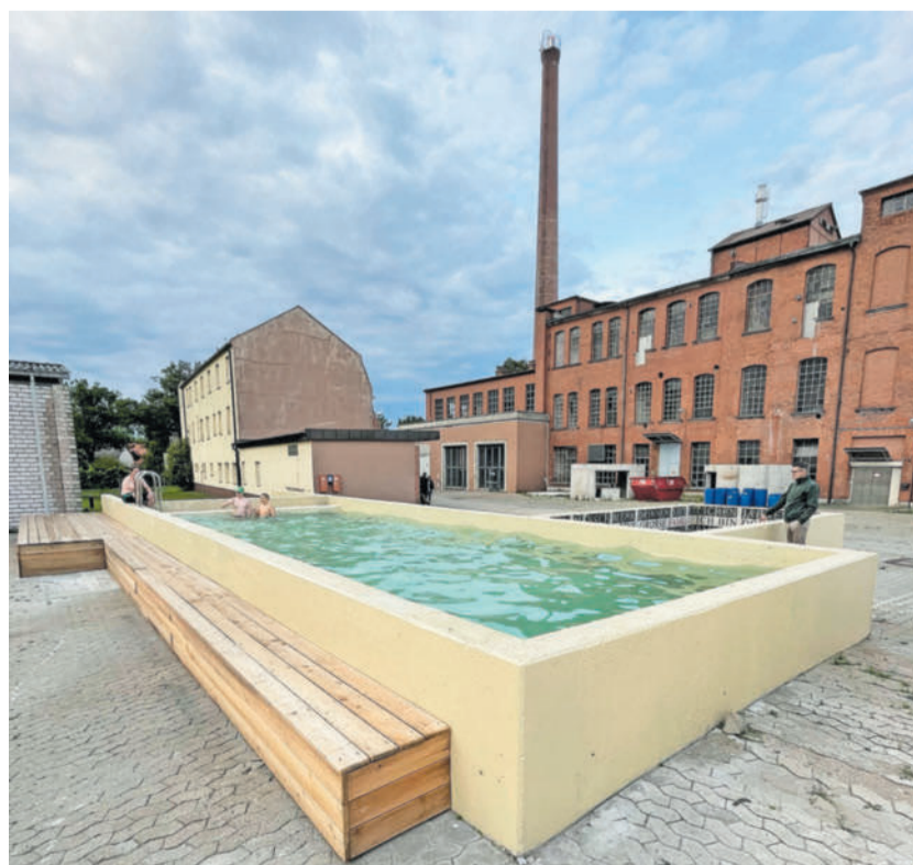
Ab ins kühle Nass: Aus einer Laune heraus verwandelte sich ein ehemaliges Kühlbecken auf dem Fabrikgelände in ein Schwimmbecken.
